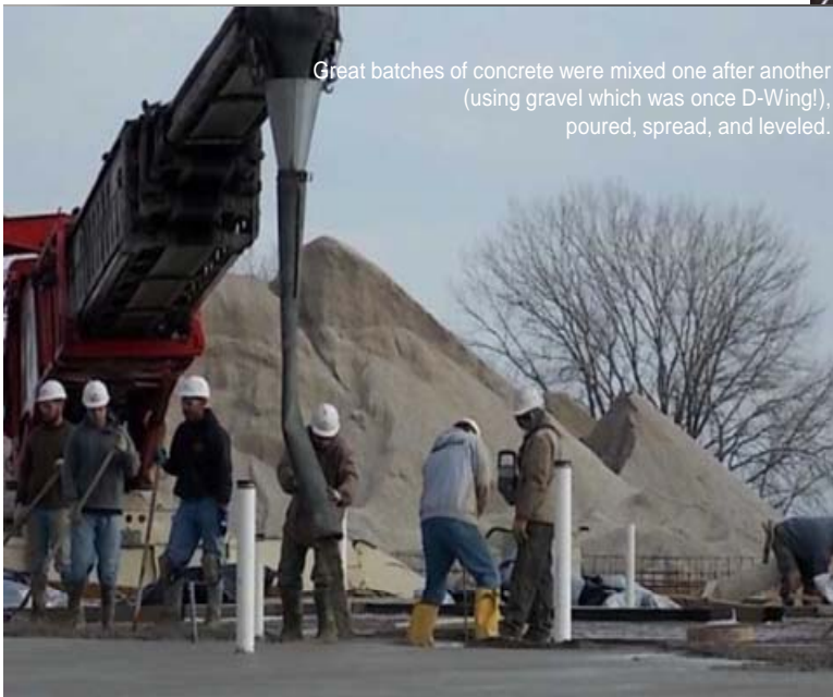
Pour concrete (recycling D-Wing)
